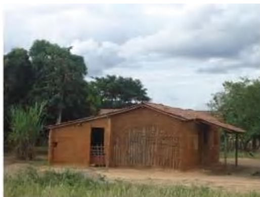
Figura 3 – Casa de taipa em Rio das Rãs
